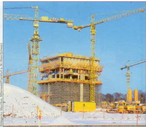
Abb. 48.1: Im Winter wird kaum gebaut.
